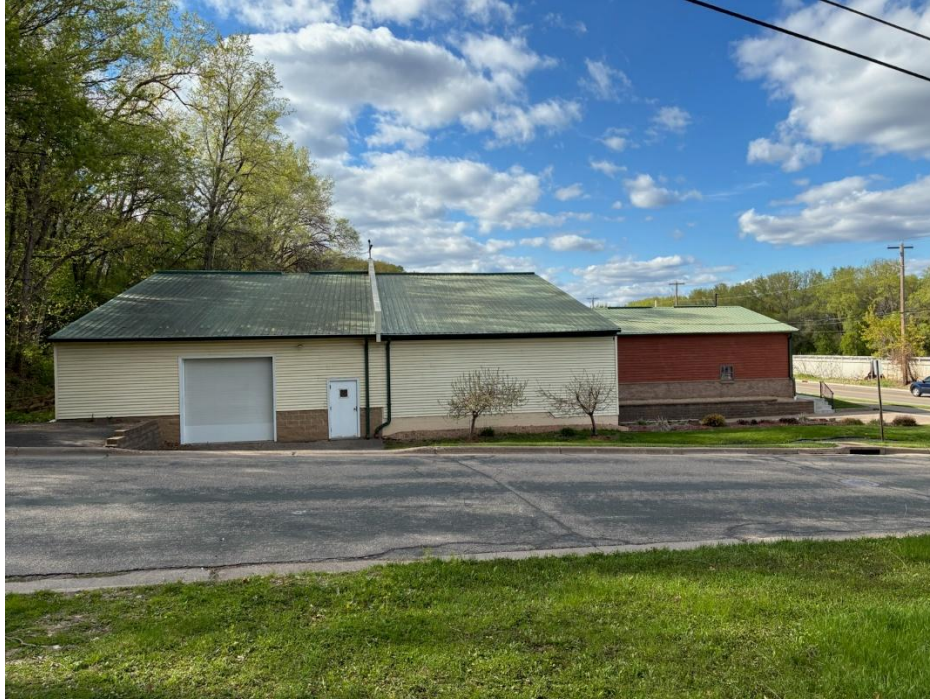
Stanley Avenue Frontage
